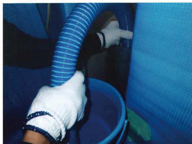
エポキシ樹脂の塗布作業
