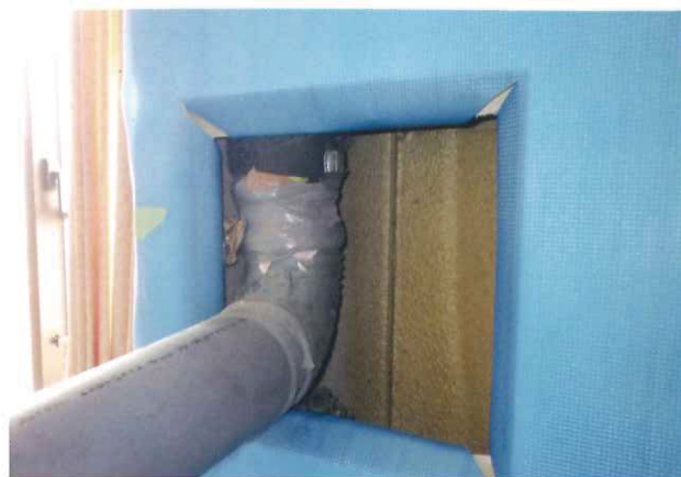
仮設吸引接続
