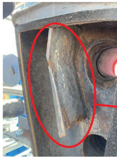
経年劣化により、仕切り板が腐食している！
