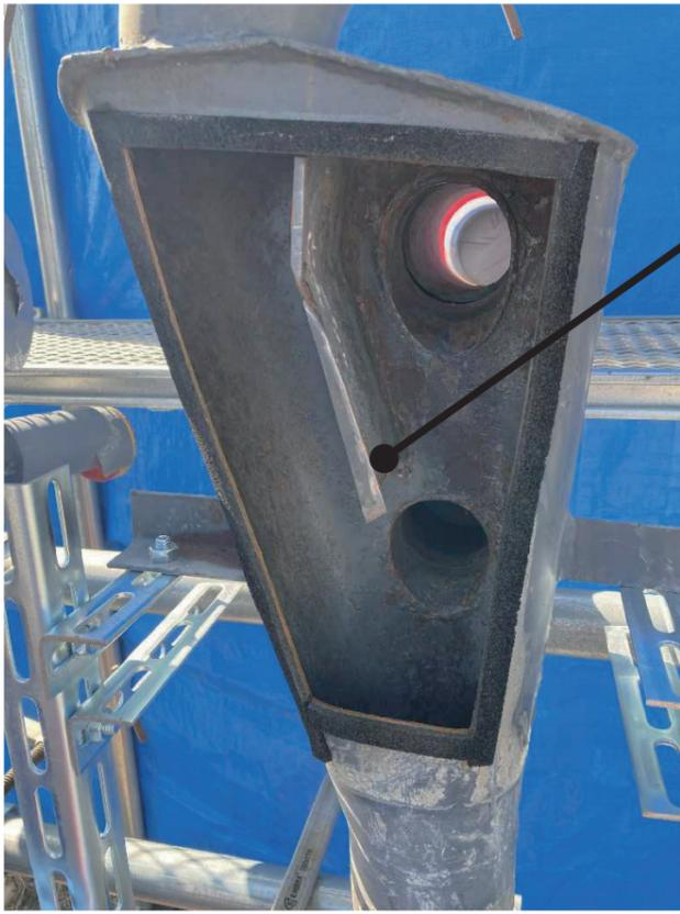
ソベント継手内部には、排水合流障害を防止する仕切り板が設置されています。
